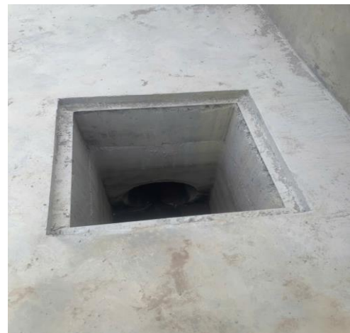
Hình ảnh đường ống thu gom nước mưa của công ty
