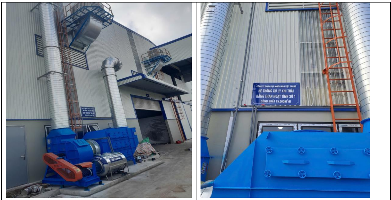
Hình 3.7. Hình ảnh hệ thống xử lý khí thải bằng than hoạt tính số 1 và số 2
